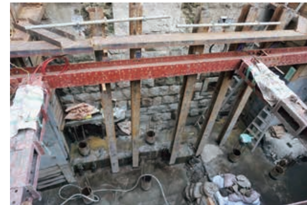
(画像1: 中央区のマンション工事現場で発掘された新川堀の石積み護岸)
