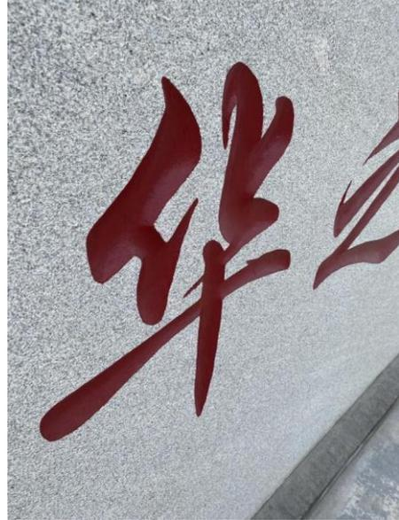
写真 17、18 機械工具で彫られ、溝がなくなった漢字
