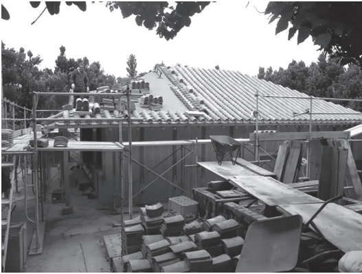
写真3 建物の修復・復元の様子
