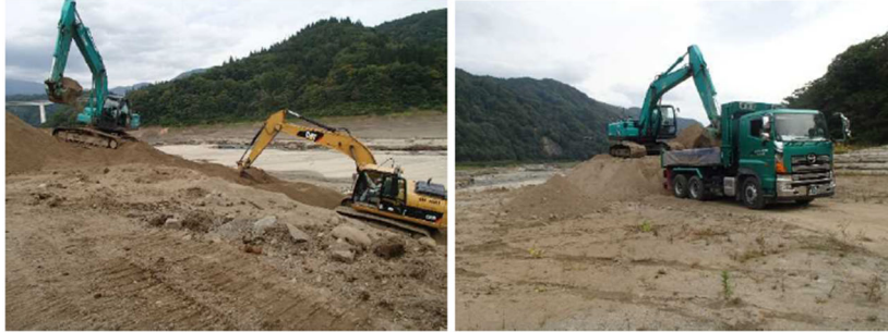
図 3.18(1) 堆砂対策 9) (平成 28 年における掘削状況)
