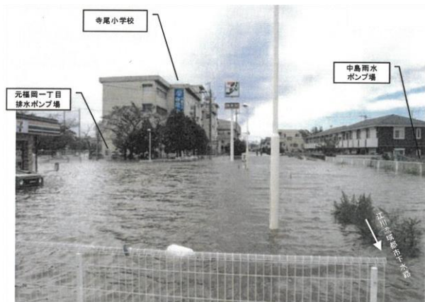
資料 8 川越市・寺尾小学校付近の冠水状況
