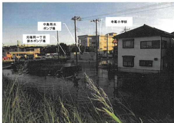
資料 10 川越市・調節池の堤防の上から見た冠水 状況
