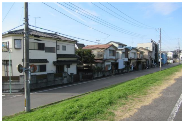
資料 11 川越市・調節池の堤防の上から見た 日常の状況
