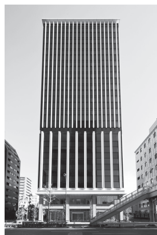
写真7 友愛会館完成写真 （提供：戸田建設）
