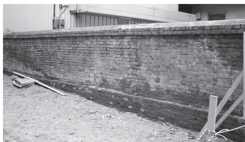
写真5 再建された煉瓦塀
