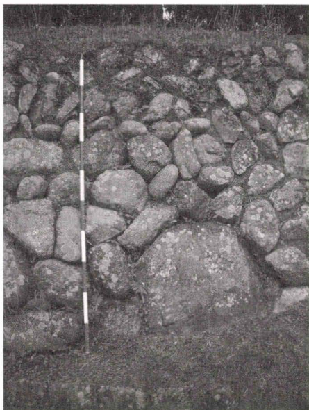
写真5 潮御崎神社宮司母屋(横屋)西側の屋敷囲い
