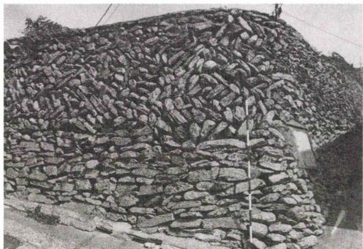
写真5 佐田岬の正野地区における隅角に曲率を有する波除け石垣
