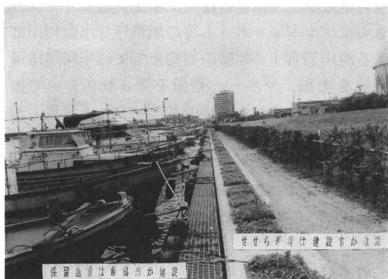
写真3 信濃川係留施設（一級河川） は堤防の修復工事と合わせ、堤防の一部コの字型にカットして係留施設を建設した。 筆者撮影（1996.7.29）
