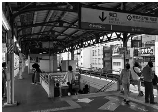
第7図 両国駅東口階段付近
