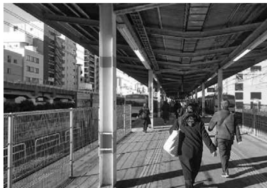
第6図 亀戸駅東口階段付近
