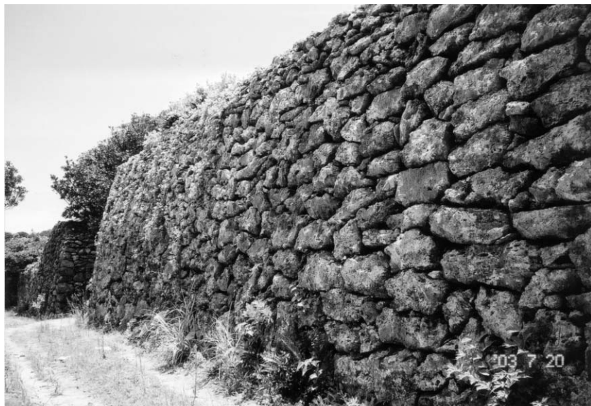
写真2 小野津集落前金久地区の西家の石垣 高さ3.7m
