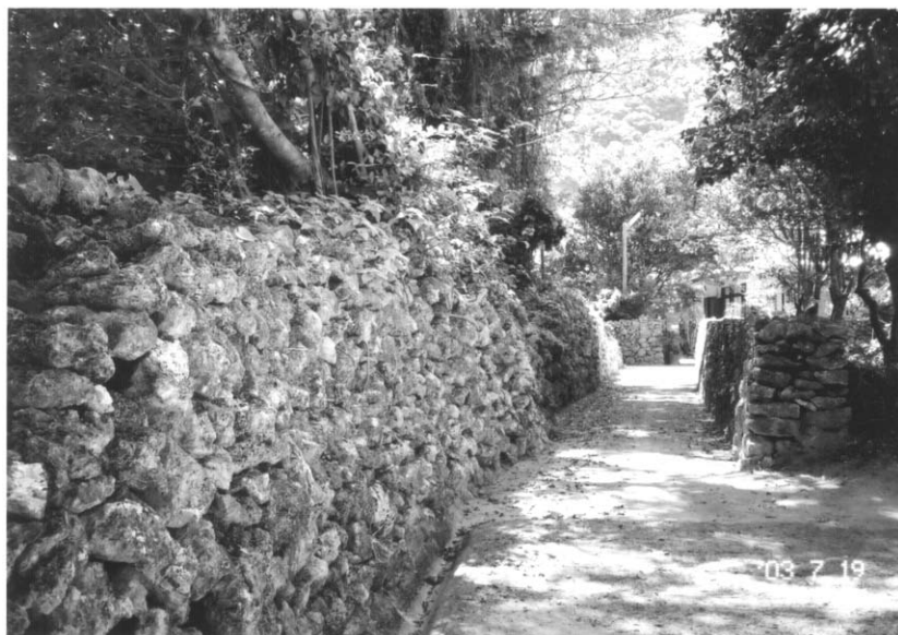
写真6 阿伝集落で最も北側の古い乱層野石積みの石垣。手前（海側）高さ2.2mから、集落の中心の高さ1.2mの石垣をのぞむ。
