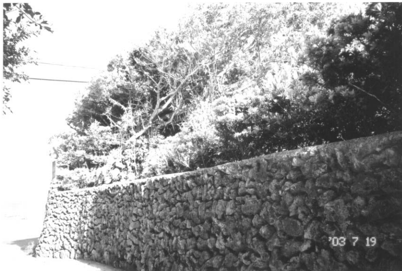
写真5 海岸に最も近い乱層野石積みの石垣。ガジュマルは偏形をうけ、グレード3～4に達している。
