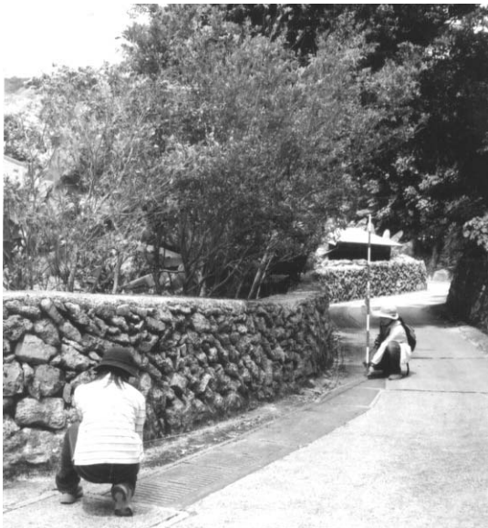
写真7 海岸から約400mの位置にある政井平進氏宅の北側の石垣。高さ約1mの乱層野石積み。
