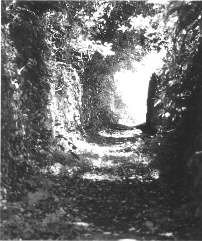
写真1 阿伝集落の北側に残る最も古い石垣と道路。(戦前の道幅をそのまま保持しており、乱層野石積みの石垣がすでに植物で覆われている)
