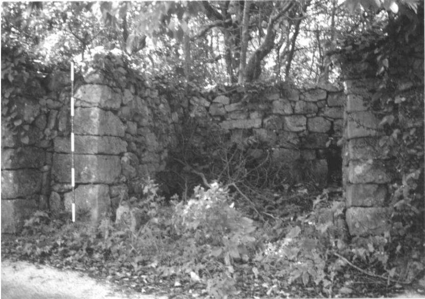
写真2 (c) 障子垣の例。すでに空家になって久しいと思われる。門の部分のみ樵石。
