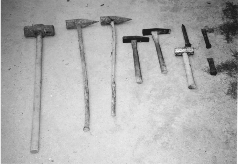
写真3 採石と樵石作りの道具。左からセットウハンマー，グミの枝の柄のハンマー2本（円錐型），石の細かい加工のためのハンマー3本，ハツリノミ（尖頭型），右2つはハツリノミ（平型）。（道具は吉沢成典氏の提供）
