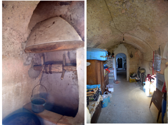
Il sistema di prelievo acqua e spazio sotto al quale si trova la cisterna (proprietà Avv. Bonocore)
