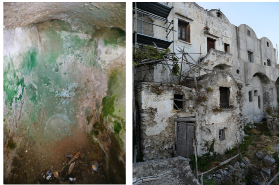
Una delle cisterne presso il borgo lungo via dei Cacciatori, dalla forma molto irregolare si può desumere che la cisterna sia stata scavata nella roccia.
