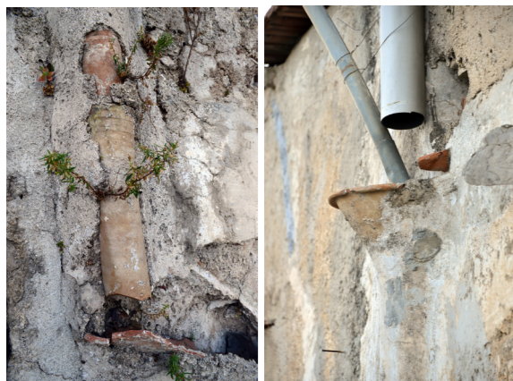
Dettagli del sistema di raccolta acqua piovana dal tetto tramite una sorta di imbuto e relativo pluviale in canoni di terra cotta che rifornivano la cisterna (borgo lungo via dei Cacciatori).
