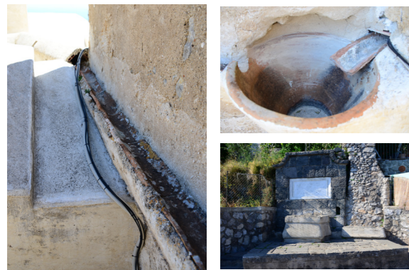
Dettagli delle canalizzazioni di approvvigionamento delle cisterne e fontana realizzata contestualmente all'acquedotto.
