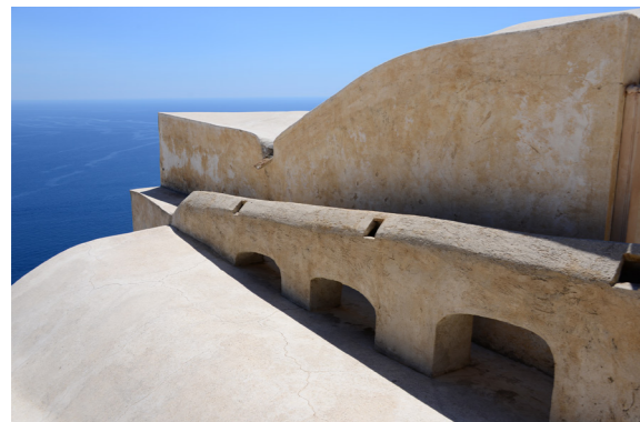
Parte terminale dell'acquedotto realizzato dal Convento S. Rosa
