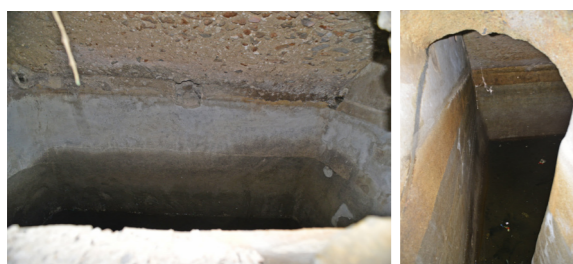
Le altre due cisterne sotto a casa Pandolfi.
