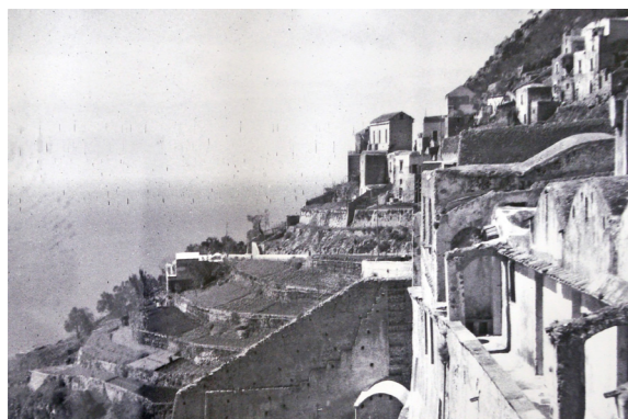
Dettaglio dei terrazzamenti a ovest del Convento Santa Rosa in un foto storica presumibilmente degli anni '40-'50.
