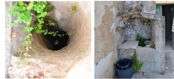
Pozzo e relativa canna per attingere acqua dalla sottostante cisterna (casa Mauro).
