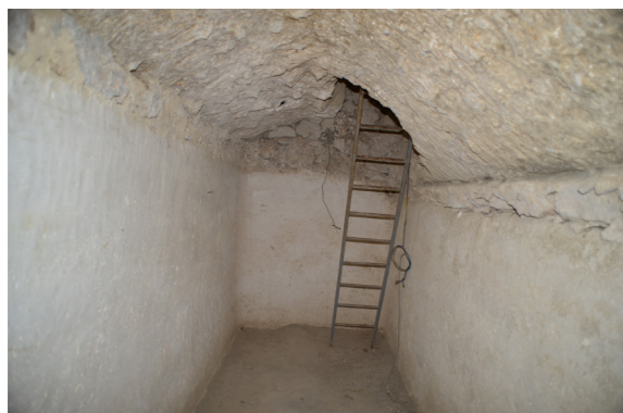
La cisterna all'interno della torre di Capo di Conca
