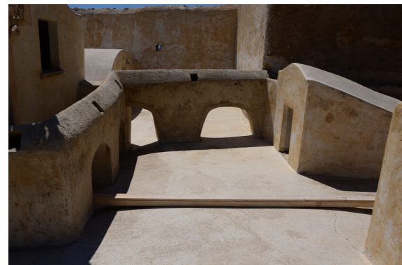
L'acquedotto del 1680 ca. approvvigionava le due cisterne del convento attraverso una complessa rete di canalizzazioni e tubature.
