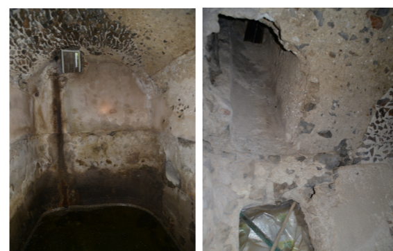
La cisterna ancora funzionante nel basamento della torre e il relativo foro per attingere acqua dai piani superiori.
