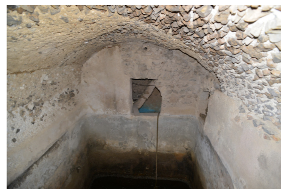
La cisterna ancora funzionante nel basamento della torre.
