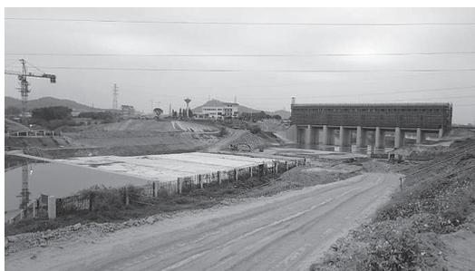
写真13 複雑に交錯する河川網を立体的に整備中(勾配の緩い河川や水路は立体交差しており、洪水対策などのため河川改修が進められていた)
