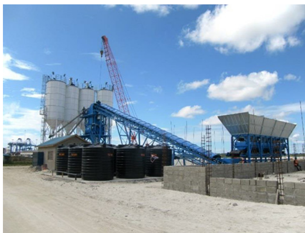
図14 生コンプラントの建設
