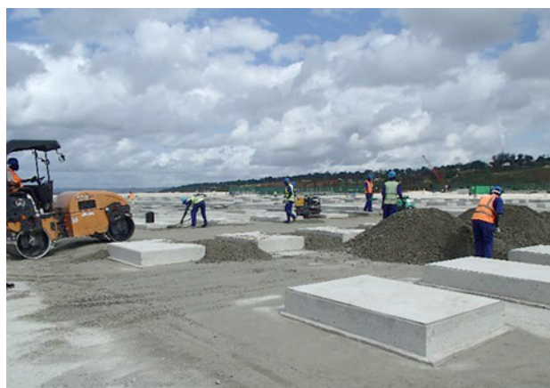
図11 コンテナヤード工の様子
