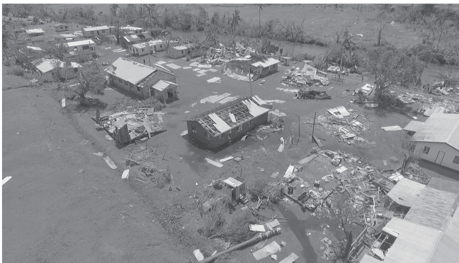
写真3 台風による被害
