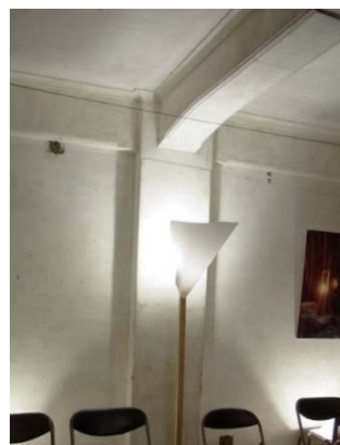
図 5-24 内部壁と柱及び梁
