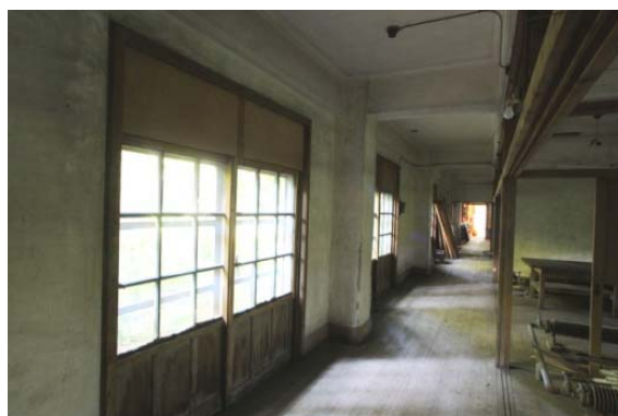
図 5-20 内部廊下と北側掃き出し窓
