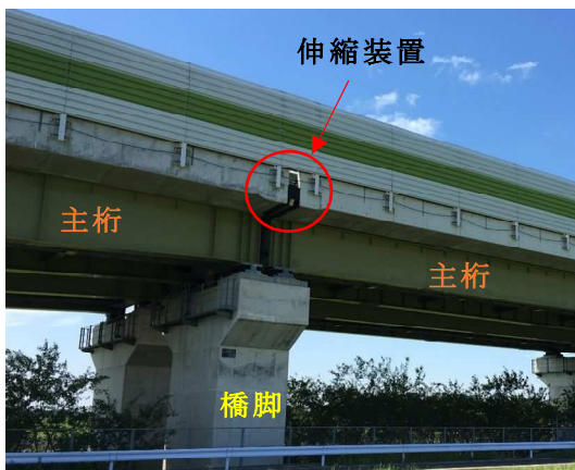
(a) 主桁と主桁の例
