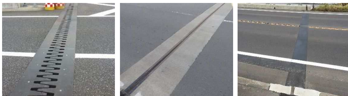
(a) 荷重支持型の例 (b) 突合せ型の例 (c) 埋設型の例
