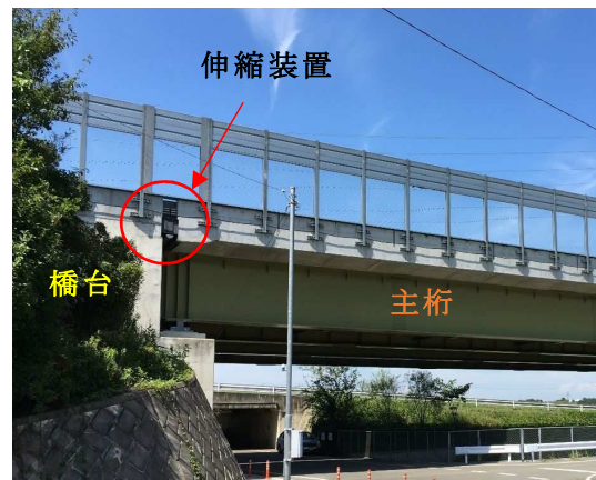
(b) 主桁と橋台の例
