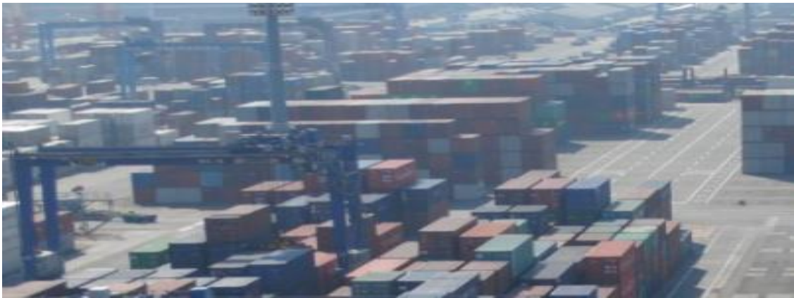
写真 2-1 トランステナー方式
