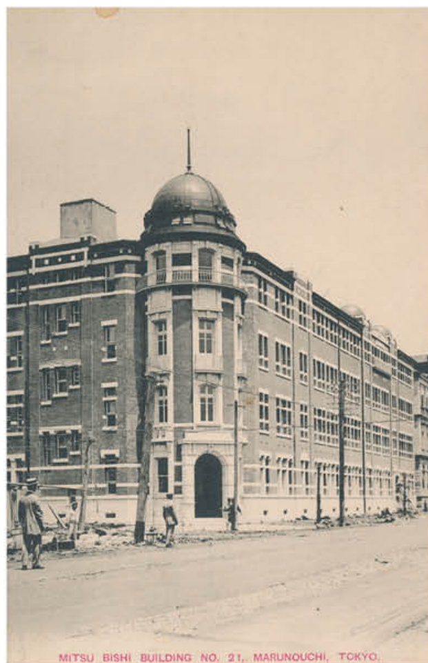
図3-8 二十一号館の竣工当初の外観
