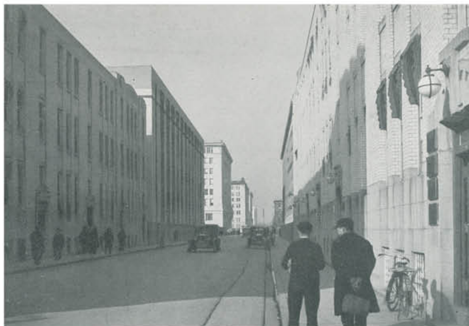
十二号館付近から仲通り南側を望む
