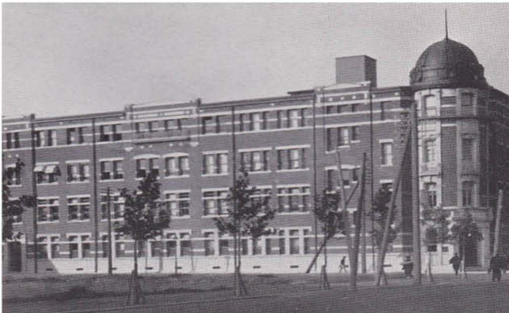
三菱第二十一号館南側外観
