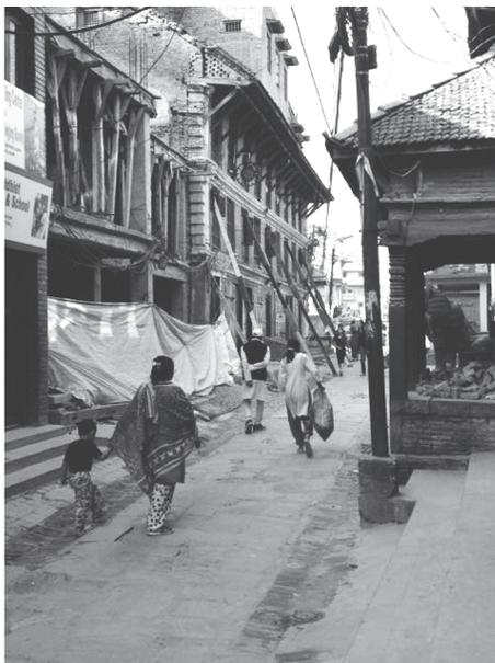
写真5 倒壊の恐れのある家屋を支えるつかい棒（テカ）（2015年5月6日撮影）
