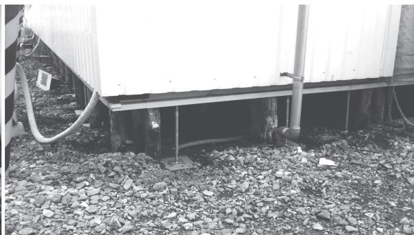
県による補強工事（鉄の板と棒による支え）
