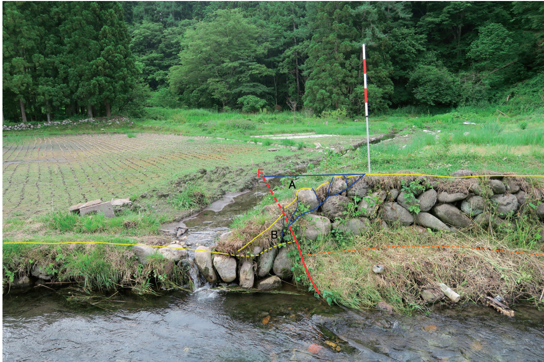
写真 7 白馬村道 0206 号線北側の小川左岸壁の地質構造（2015.6.22. 撮影）
