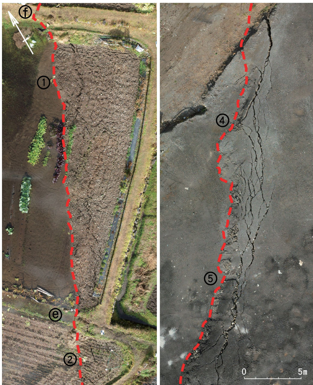
写真6 変動崖の崖面に発達する亀裂群
