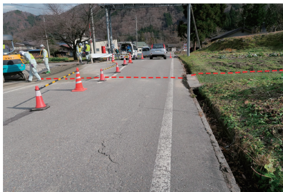
写真5 大出地区で国道406号線を横断して生じた変動崖（2014.11.24.撮影）
