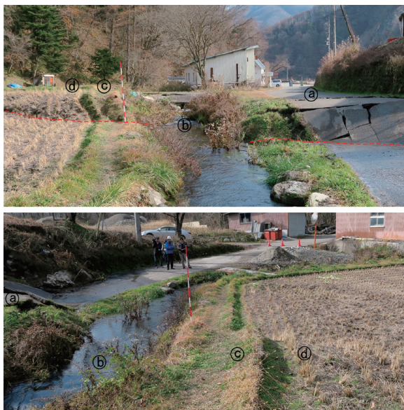
写真2 顕著な左横ずれ痕跡 (a~d) (2014.11.24.撮影)
