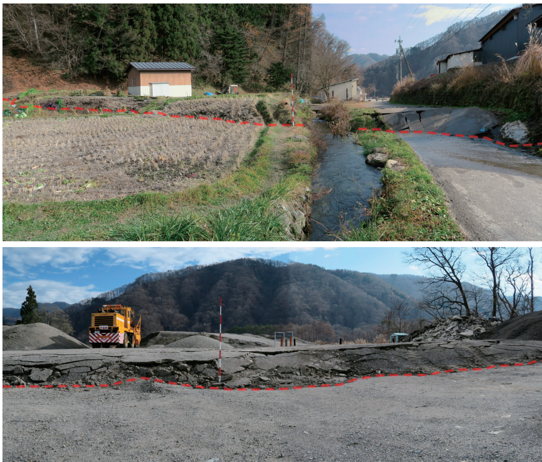
写真1 白馬村森上地区東端部（城山南麓部）に生じた変動崖（2014.11.24.撮影）
