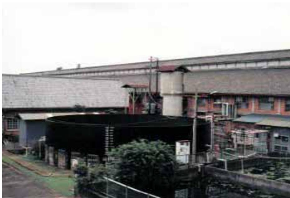
写真18は大きな鉄の水槽です。直径が14メートルございます。高さが3メートルぐらいあるのです。生糸をとるためにはどうしても水を軟水化させて、それを製糸に使わないといい生糸がとれません。そのために当初はレンガによる水槽をつくったのですが、1年半ぐらいで水漏れがしてくるのです。それでやむを得ず、新たに鉄の水槽をつくるのですが、これだけが国産品なのです。明治8年の正月には多分、ここに据え付けられたかと思うのですが、慶應元年に横浜製鉄所ということができます。それがやがて名称を変えて横浜製作所になりますが、そこでつくったものを、ここへどういう方法
