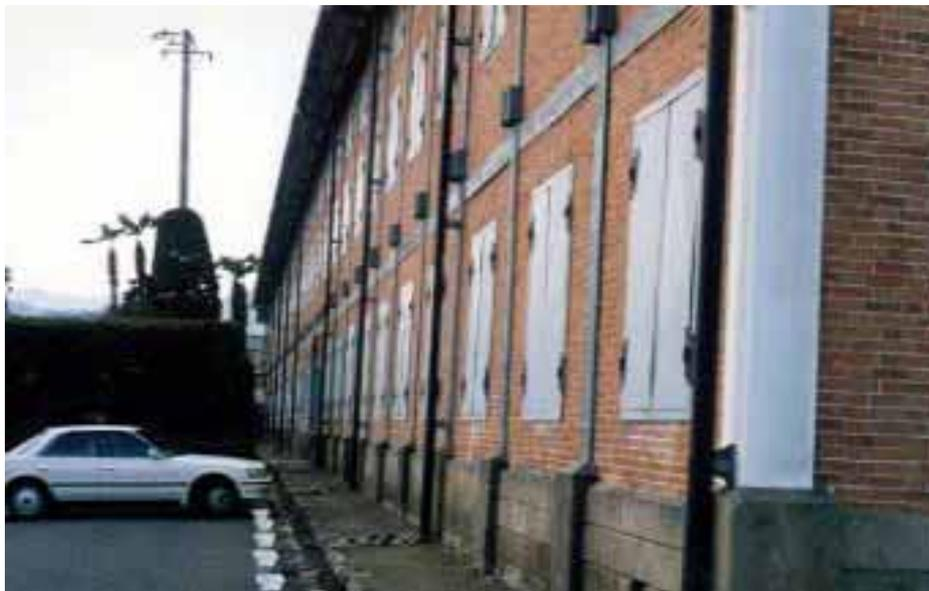
写真 3 は北の方から南に向かって撮った写真でございます。特に注目していただきたいのは、礎石を非常に多く使っているということ。そして礎石の上に通し柱を建てています。柱の 1 辺が 1 尺以上でございます。屋根まで継ぎ目なしの柱を建てて、その間にレンガを積んでいると、こういう形です。
