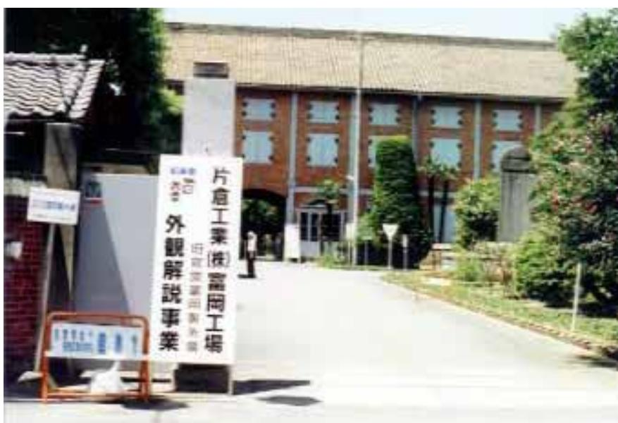
写真 1 が東繭倉庫といわれる建物です。東から入って、ここが正面入り口で、アーチが 1 つございます。建物は木骨レンガ造といい、木の柱と壁の部分にレンガを積み上げた構造です。これは 2 階建てでございまして、これが 2 階の根太になる部分です。2 階が繭倉庫です。建物が全部映っておりませんが、この全体の長さが約 104 メートルございます。棟の高さが約 14 メートル、幅が約 12 メートルで、物すごく大きな建物が、現在、こういう形で残っております。
