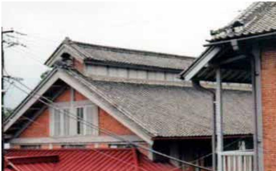
写真 9 が東蘭倉庫とそれに直行する形で向こうにずっと線糸場が延びております。これだけでは長さがわかりませんが約 140 メートルございます。幅が 12.3 メートル、高さが 11.6 メートル、上に越し屋根をつけております。これは操業すると場内にたいへん蒸気が充満しますから、その蒸気抜きです。
