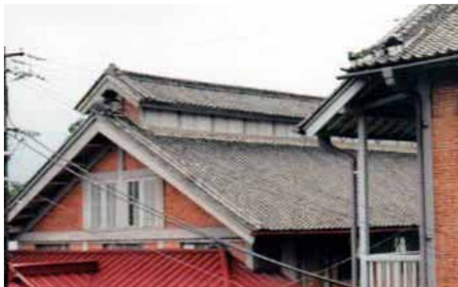
写真 9 が東蔵倉庫とそれに直行する形で向こうにずっと繰糸場が延びております。これだけでは長さがわかりませんが約 140 メートルございます。幅が 12.3 メートル、高さが 11.6 メートル、上に越し屋根をつけております。これは操業すると場内にたいへん蒸気が充満しますから、その蒸気抜きです。
