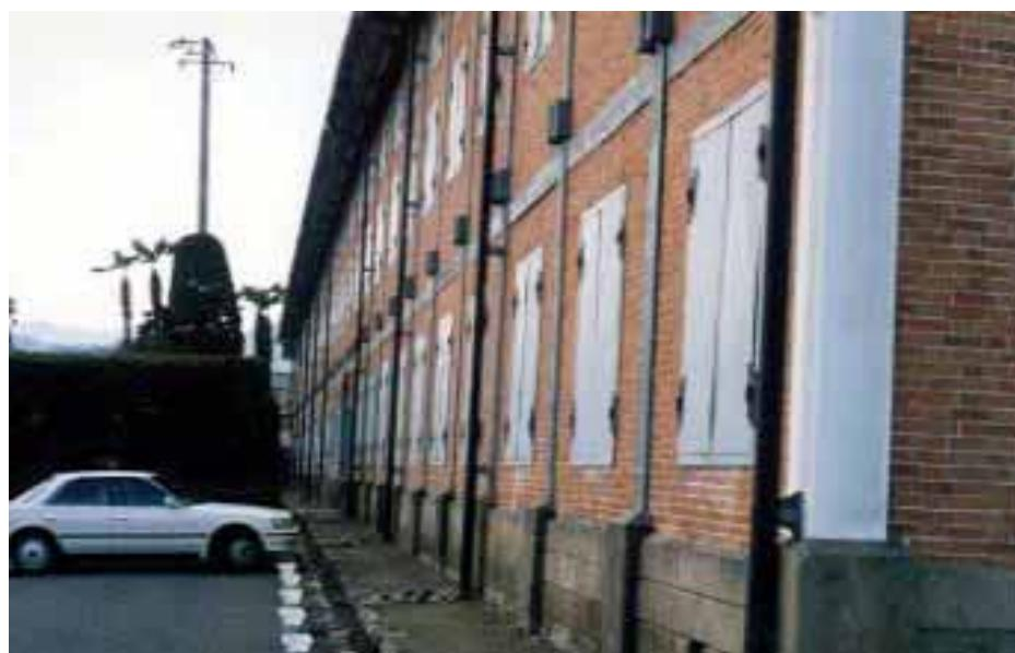
写真 3 は北の方から南に向かって撮った写真でございます。特に注目していただきたいのは、磁石を非常に多く使っているということ。そして磁石の上に通し柱を建てています。柱の 1 辺が 1 尺以上ございます。屋根まで継ぎ目なしの柱を建てて、その間にレンガを積んでいると、こういう形です。
