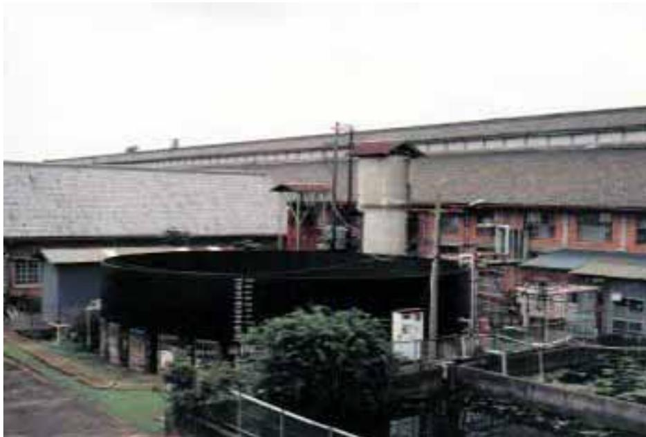
写真 18 は大きな鉄の水槽です。直径が 14 メートルございます。高さが 3 メートルぐらいあるのです。生糸をとるためにはどうしても水を軟水化させて、それを製糸に使わないといい生糸がとれません。そのために当初はレンガによる水槽をつくったのですが、1 年半ぐらいで水漏れがしてくるのです。それでやむを得ず、新たに鉄の水槽をつくるのですが、これだけが国産品なのです。明治 8 年の正月には多分、ここに据え付けられたかと思うのですが、慶応元年に横浜製鉄所というのができます。それがやがて名称を変えて横浜製作所になりますが、そこでつくったものです。横浜でつくったものを、ここへどういう方法
