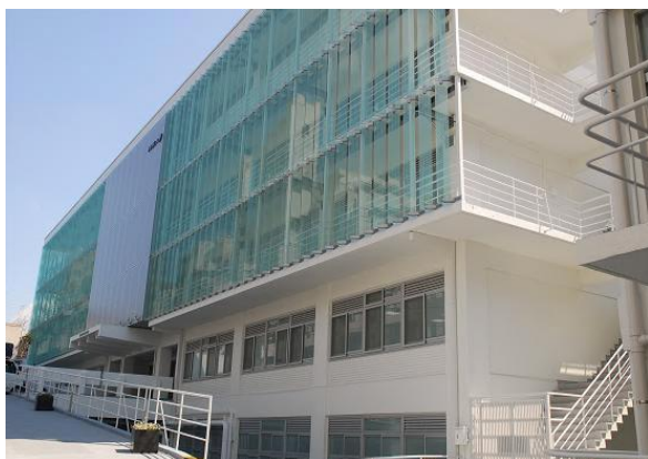
図.1 対象建物の外観
