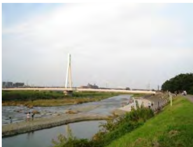
写真 6. 浅川に架かる歩道橋のふれあい橋
