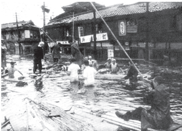
図5-5 大正区三軒家附近 (ジェーン台風直後) 出典：前出『西大阪高潮対策事業誌』、巻頭・ジェーン台風被害写真
