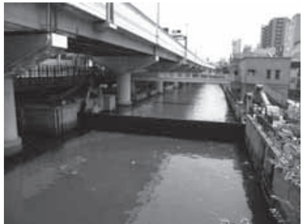
図 5-18 東横堀川水門全景
