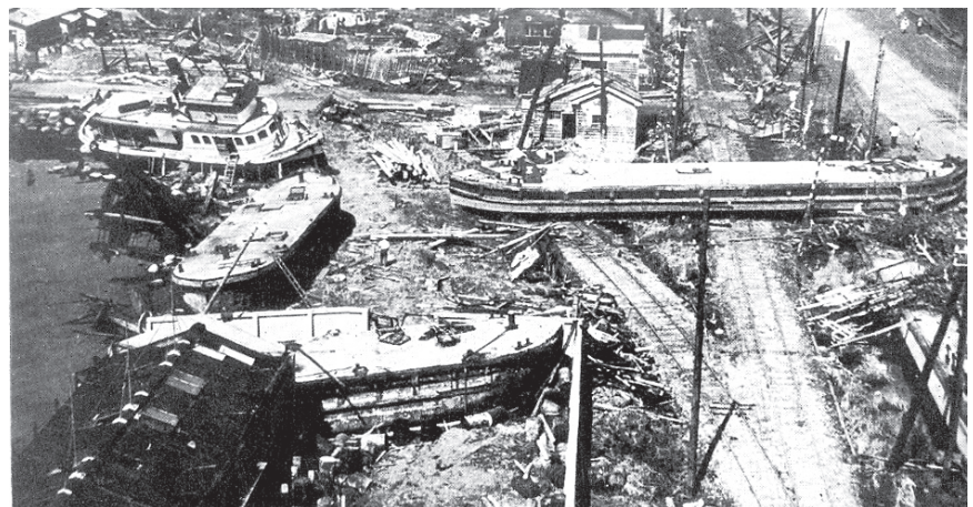
図5-6 港区第二突堤 (ジェーン台風直後) 出典：前出『西大阪高潮対策事業誌』、 巻頭・ジェーン台風被害写真
