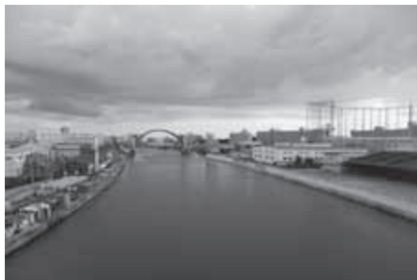
図 5-11 上流から見た木津川水門遠景
