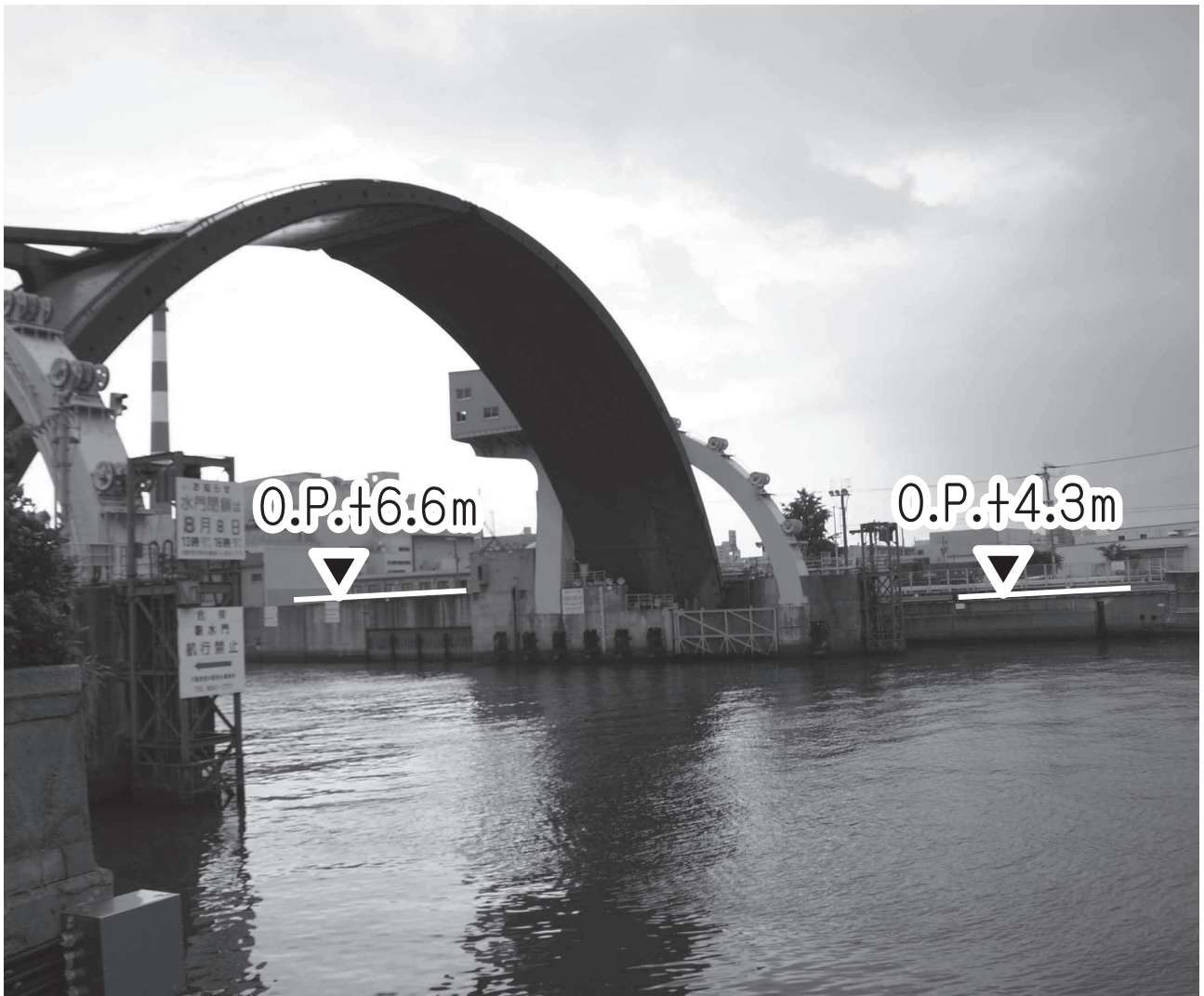
図 5-12 木津川水門の上下流における堤防高 画面右側：上流、画面左側：下流
