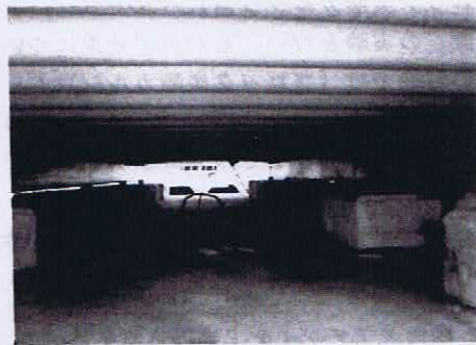
写真7. トタンの下空気層 230 mm
