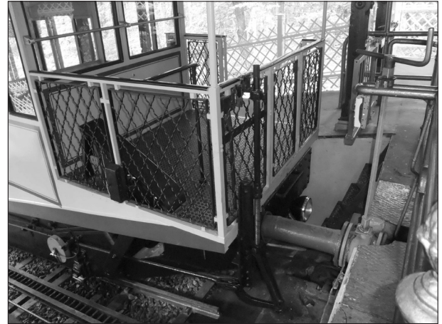
図-3 水力ケーブルカーの上駅での注水。注水パイプが車両の取水口に自動的にはめ込まれる。
