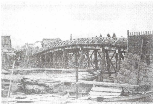
図 1-6 日本橋（太鼓橋）
