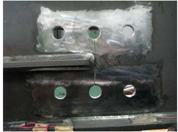
写真-2.14 WG1-S 添え板設置前状況
