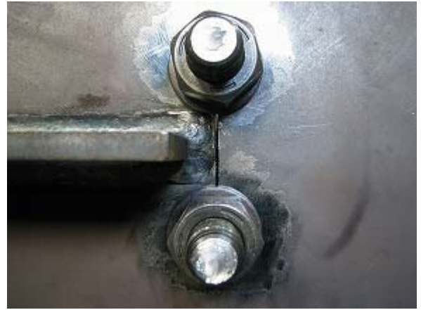
写真-2.86 WG2-N ボルト締め後状況
