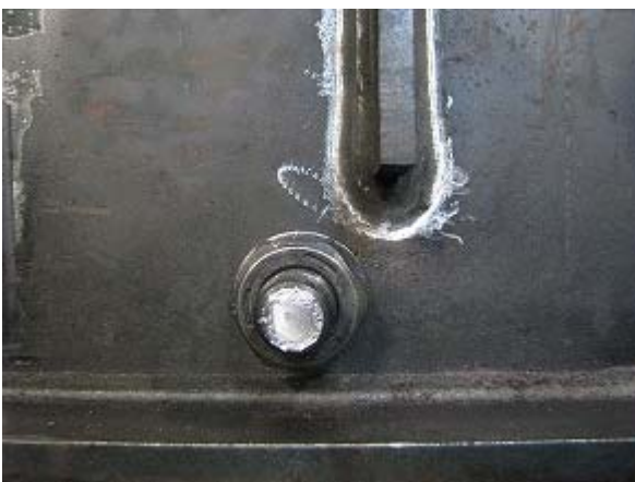
写真-2.125 垂直補剛材 北側補修状況
