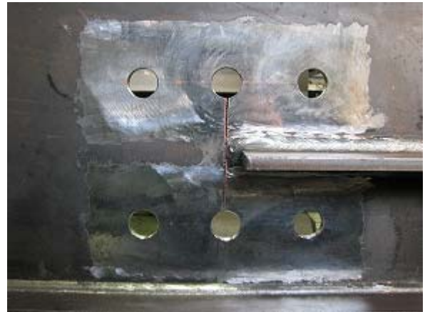
写真-2.52 WG3-S 添え板設置前状況
