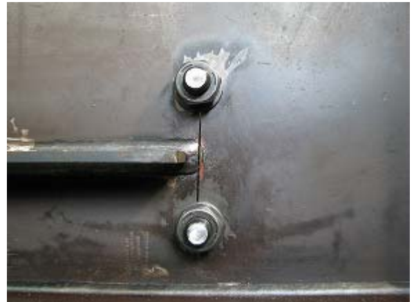
写真-2.58 WG2-N ボルト締め後状況
