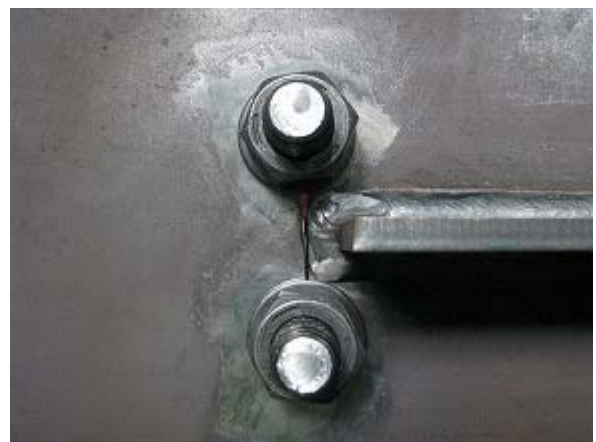
写真-2.102 WG2-S ボルト締め後状況
