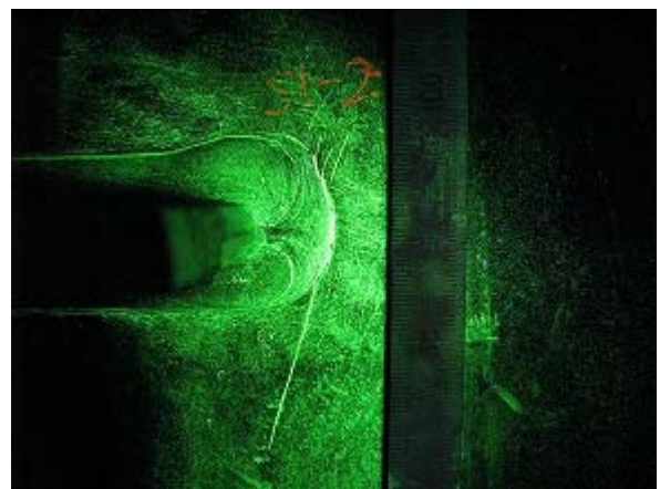
写真-2.12 WG1-S 補修前き裂 (西面)
