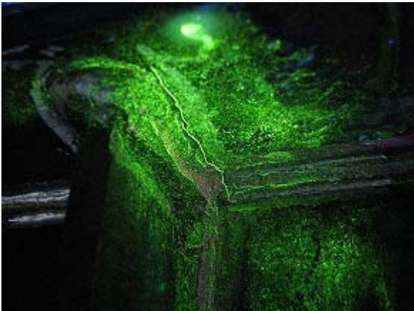
写真-2.159 載荷点 北側東面き裂状況(2)
