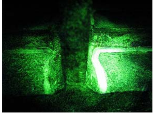
写真-2.170 支点 北側西面試験終了後
