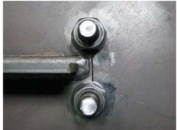
写真-2.100 WG2-N ボルト締め後状況
