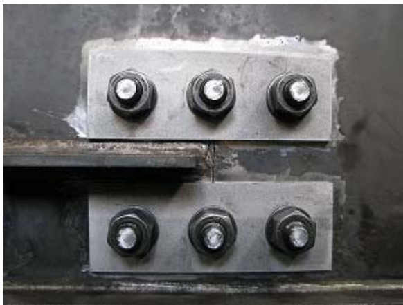
写真-2.33 WG1-N 添え板設置後状況
