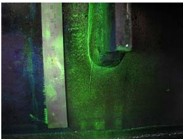
写真-2.113 垂直補剛材 南側東面き裂
