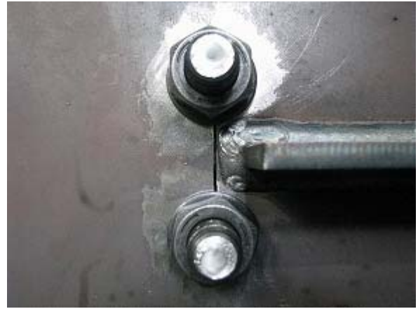
写真-2.98 WG1-S ボルト締め後状況
