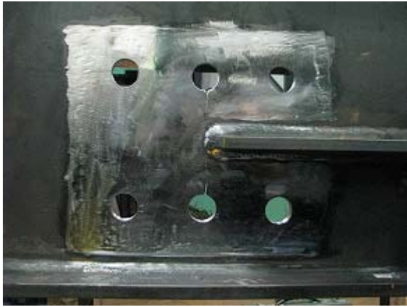
写真-2.19 WG2-N 添え板設置前状況
