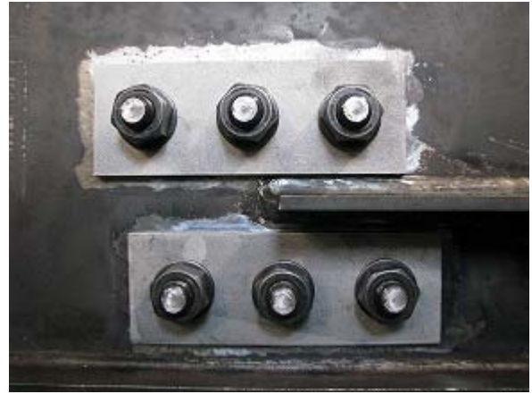
写真-2.38 WG1-S 添え板設置後状況
