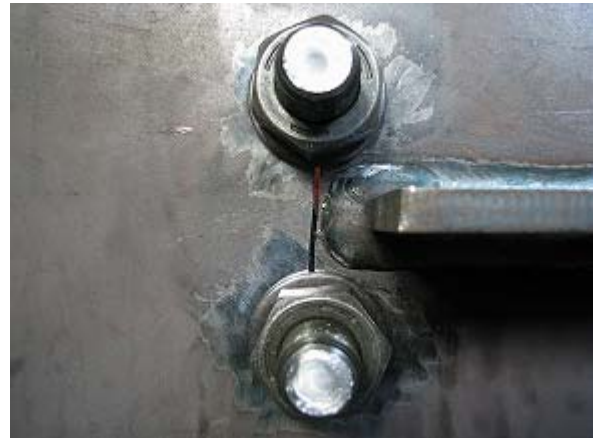
写真-2.88 WG2-S ボルト締め後状況
