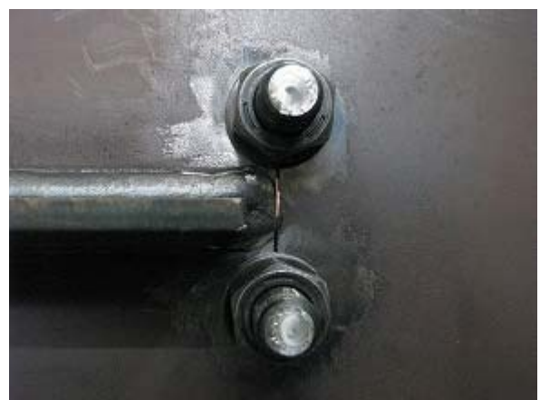
写真-2.96 WG1-N ボルト締め後状況
