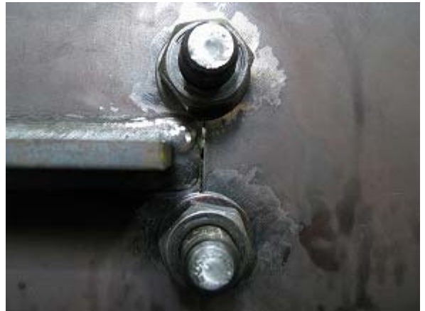
写真-2.82 WG1-N ボルト締め後状況
