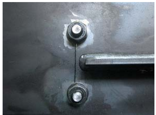
写真-2.78 WG3-S ボルト締め後状況
