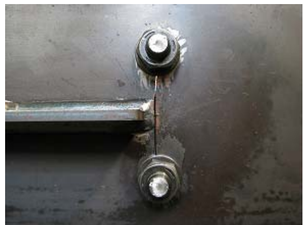
写真-2.54 WG1-N ボルト締め後状況
