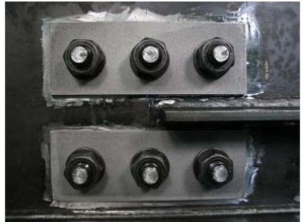
写真-2.46 WG2-S 添え板設置後状況
