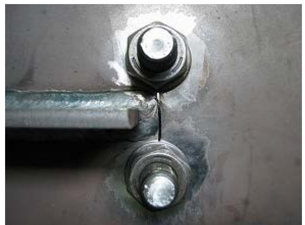
写真-2.90 WG3-N ボルト締め後状況
