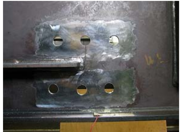
写真-2.28 WG3-N 添え板設置前状況
