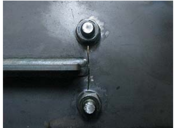
写真-2.68 WG1-N ボルト締め後状況
