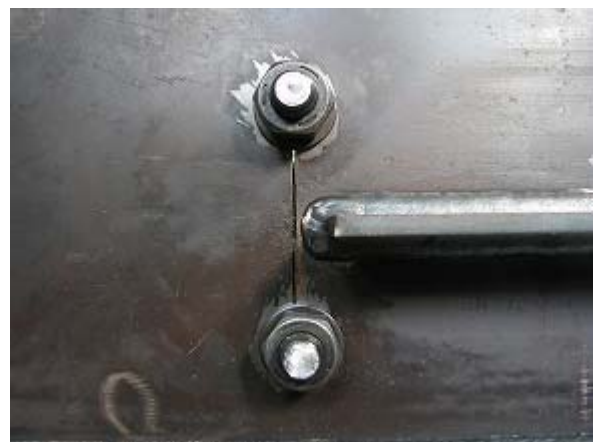
写真-2.60 WG2-S ボルト締め後状況
