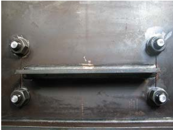
写真-2.7 B試験体 ボルト締め後
