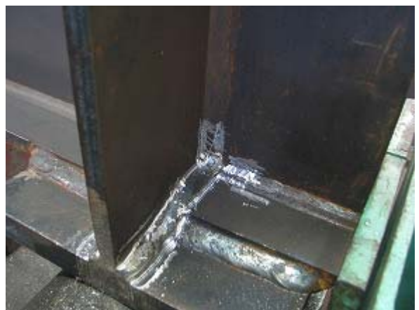
写真-2.174 支点 止端仕上げ状況
