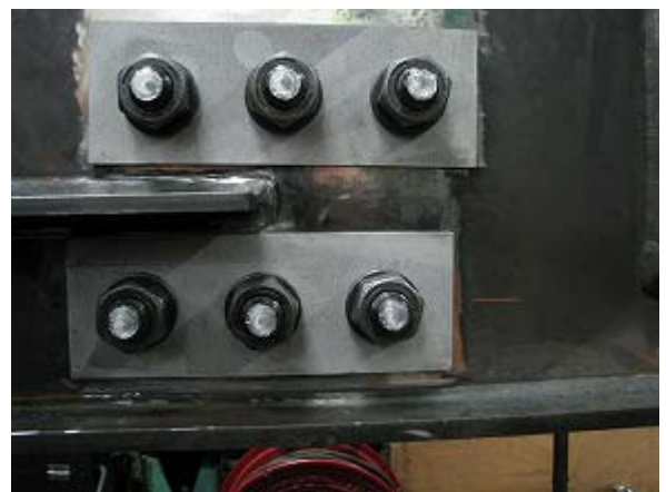
写真-2.24 WG2-S 添え板設置後状況
