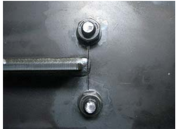
写真-2.76 WG3-N ボルト締め後状況
