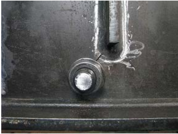
写真-2.127 垂直補剛材 南側補修状況
