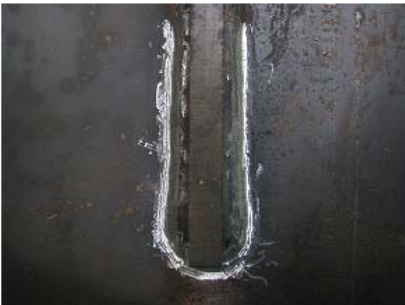
写真-2.119 垂直補剛材 止端仕上げ状況
