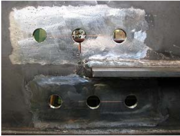
写真-2.37 WG1-S 添え板設置前状況
