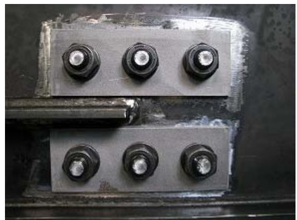
写真-2.42 WG2-N 添え板設置後状況
