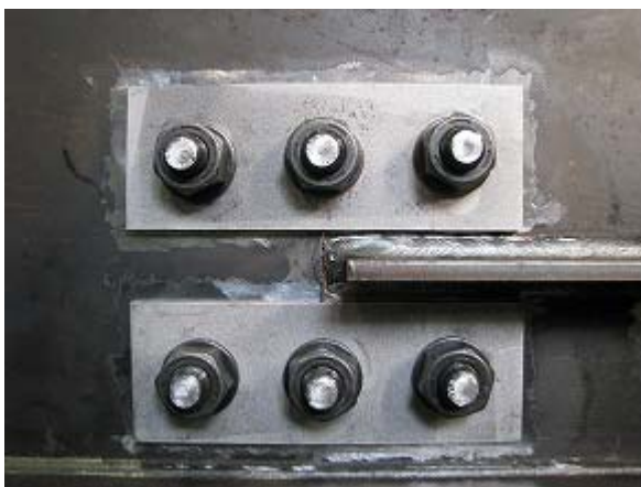
写真-2.53 WG3-S 添え板設置後状況
