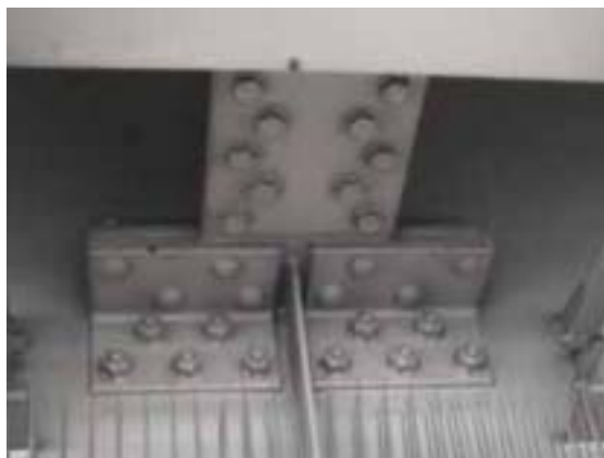
写真-1.5 アングル材による補強
