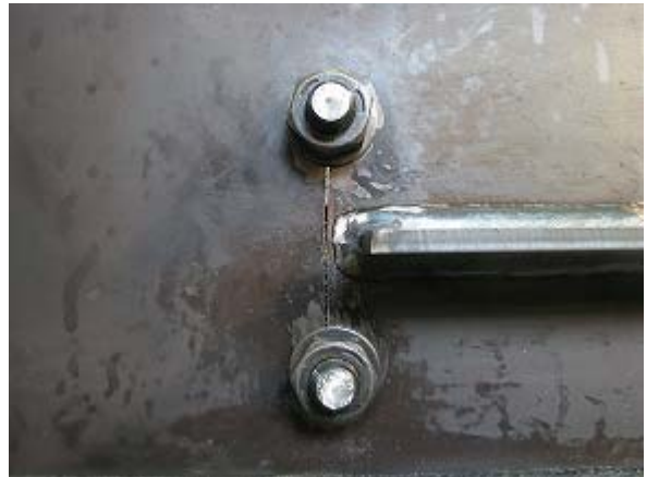
写真-2.64 WG3-S ボルト締め後状況
