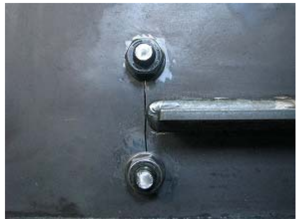
写真-2.70 WG1-S ボルト締め後状況
