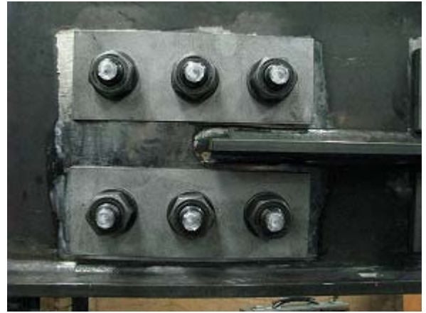
写真-2.20 WG2-N 添え板設置後状況
