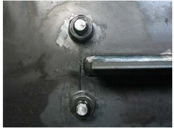
写真-2.74 WG2-S ボルト締め後状況
