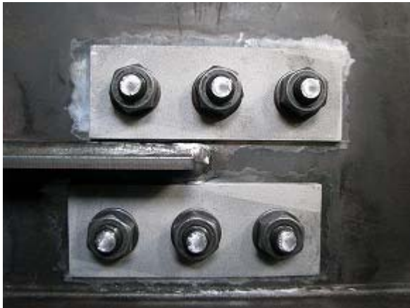
写真-2.51 WG3-N 添え板設置後状況
