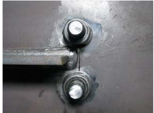
写真-2.104 WG3-N ボルト締め後状況
