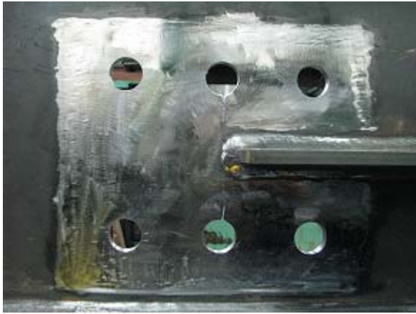
写真-2.1 A試験体 添え板設置前(疲労き裂有)
