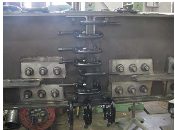
写真-2.114 垂直補剛材補修状況
