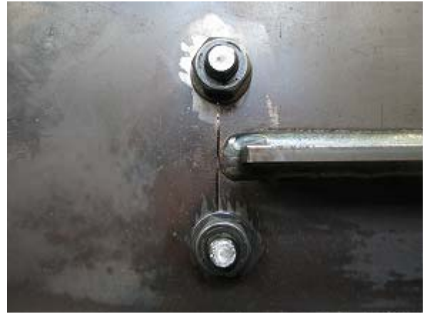
写真-2.56 WG1-S ボルト締め後状況
