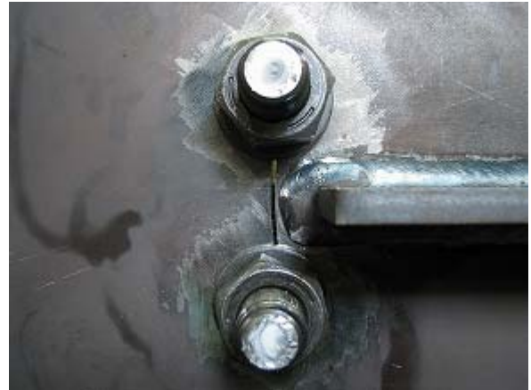
写真-2.92 WG3-S ボルト締め後状況
