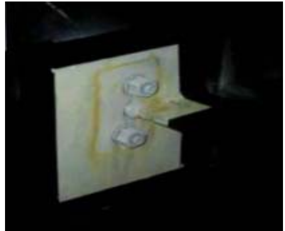
写真-1.4 ボルト締めストップホール法
