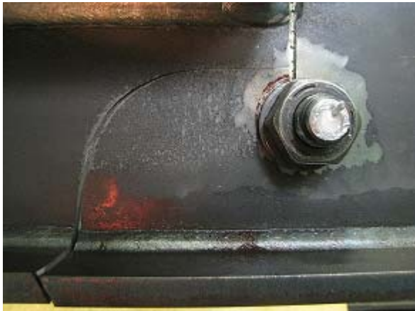
写真-2.81 B-2 試験体下フランジ破断状況
