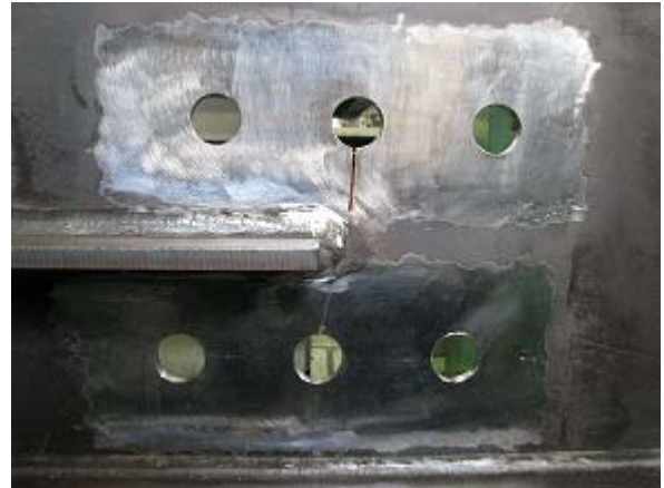
写真-2.50 WG3-N 添え板設置前状況
