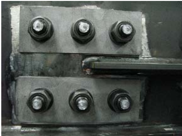
写真-2.3 A試験体 添え板設置後
