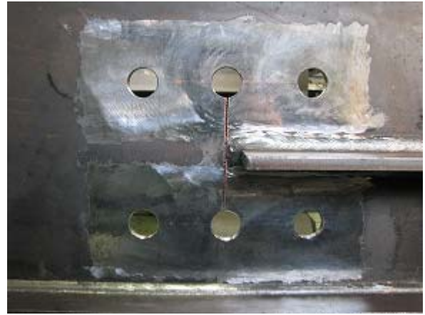
写真-2.2 A試験体 添え板設置前(疲労き裂無)
