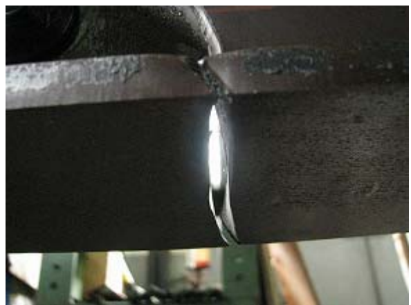
写真-2.66 B-1 試験体下フランジ破断状況
