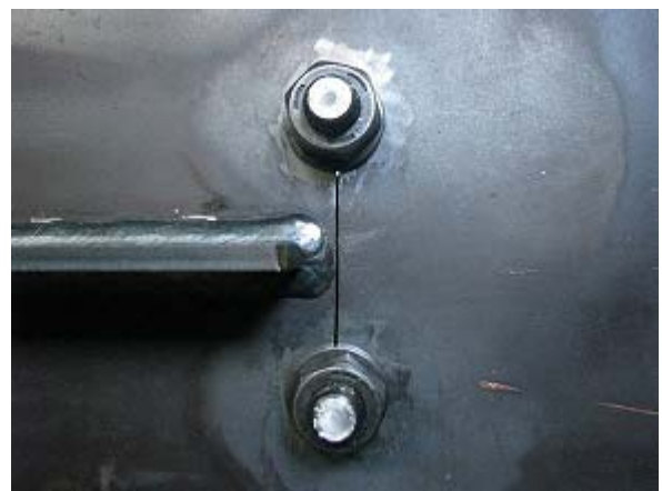
写真-2.72 WG2-N ボルト締め後状況
