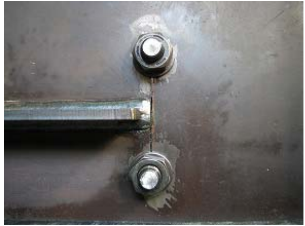
写真-2.62 WG3-N ボルト締め後状況
