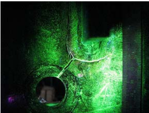
写真-2.137 垂直補剛材 南側東面試験終了後
