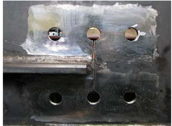
写真-2.32 WG1-N 添え板設置前状況
