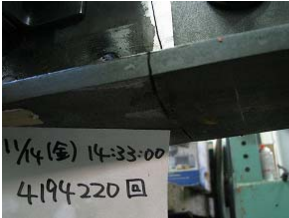
写真-2.31 A-1 試験体下フランジ破断状況
