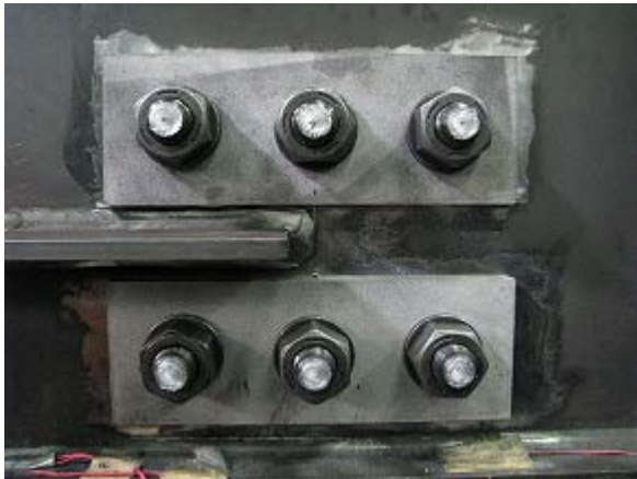
写真-2.15 WG1-S 添え板設置後状況
