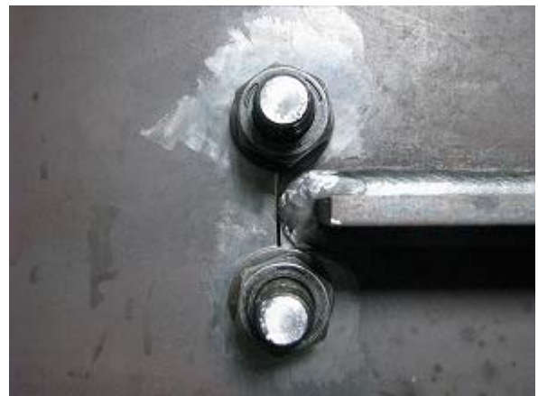
写真-2.106 WG3-S ボルト締め後状況
