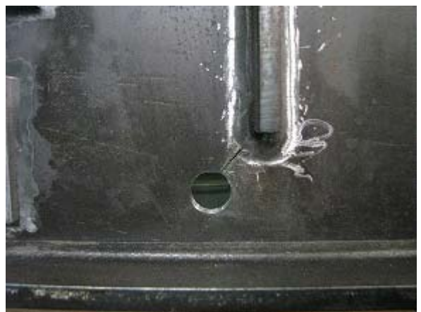
写真-2.126 垂直補剛材 南側補修状況
