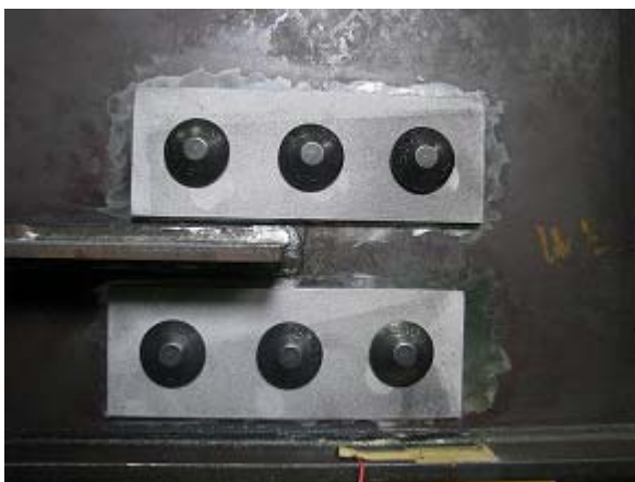
写真-2.29 WG3-N 添え板設置後状況
