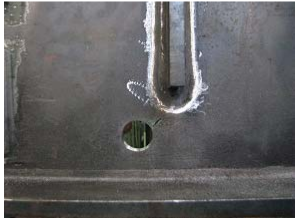
写真-2.124 垂直補剛材 北側補修状況
