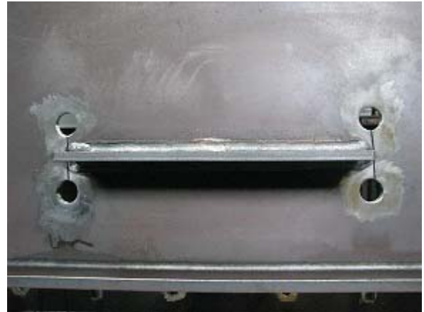
写真-2.8 C試験体 ボルト締め前
