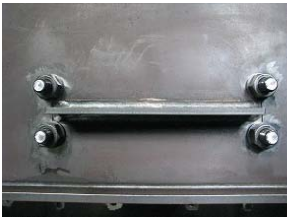
写真-2.9 C試験体 ボルト締め後
