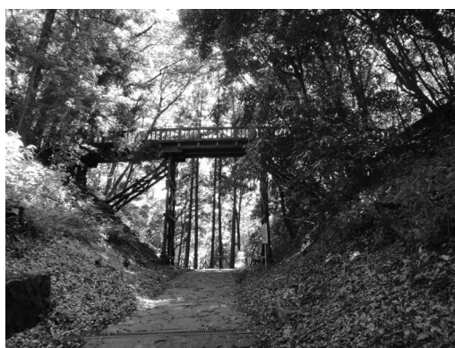
本丸と中の丸を繋ぐ引橋
