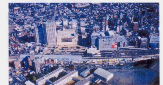
橋本駅北口周辺 (完成後)
