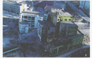
図 2-47 解体中の上海ビール工場 （『時代建築 2006-2』 同済大学出版社 2006.3）
