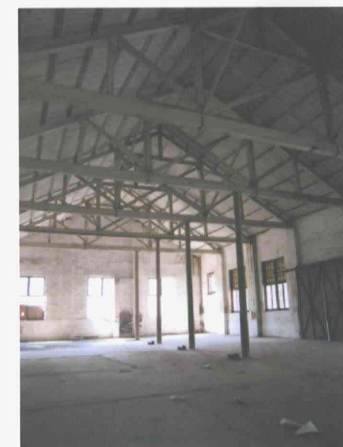
図 2-40,41,42 解体を免れた莫干山路120号の建物
