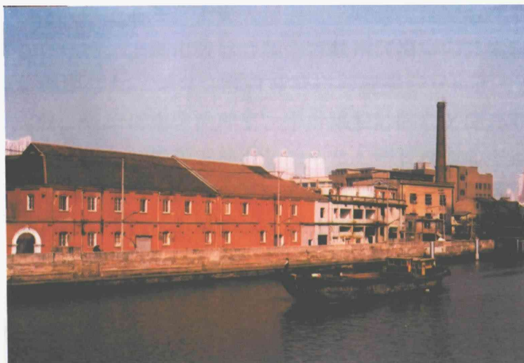
図 2-34 西蘇州路 1131 号・ 1133 号倉庫外観 (韓好齊 張松著『東方的塞納左 岸』上海古籍出版者 2004.5)
