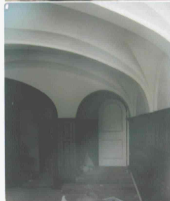
図 2-52,53 オフィス外観および内部
