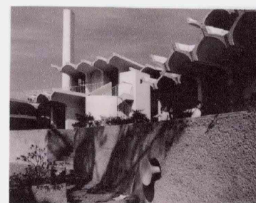
ゆかり幼稚園のパラボラ曲面を持つ プレキャストコンクリート
