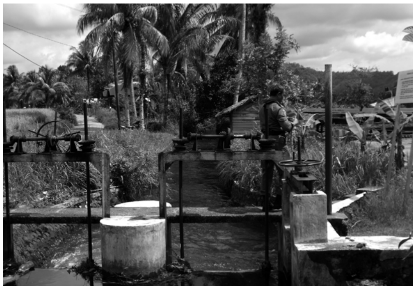
写真9 シチャウン灌漑水路で日中と夜間の給水を制御する水門。立っているのは、元共有地返還運動の闘士のT氏。現在は、県警備隊になることを強要された。
