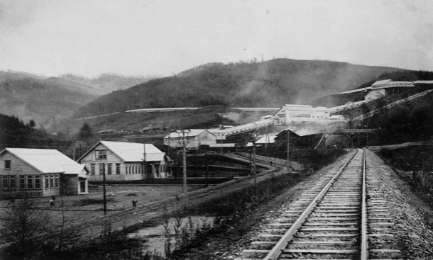
三井美唄鐵礦炭積込場
