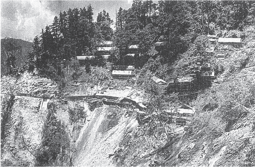
図7 自然破壊の工事（第4工区作廊谷労働者宿舎）
