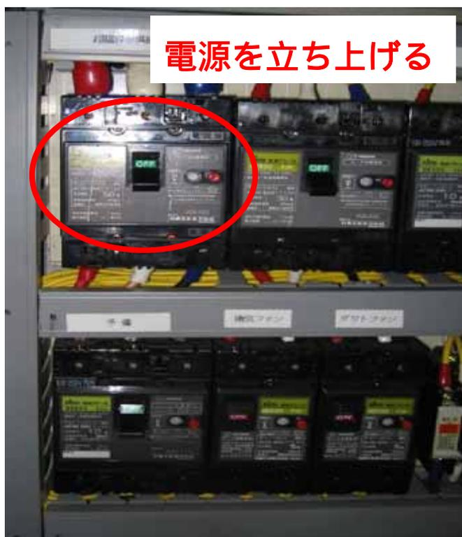
(3)実験装置に近いパネル内のブレーカーを立ちあげる。
