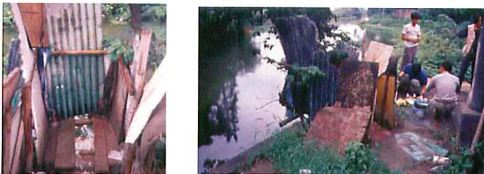
写真Ⅲ-5・7 水路に張り出した簡易トイレ
