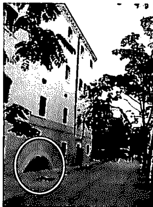
写真 2-3-25 かつての地下水路跡
