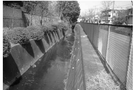
写真 4.43 緑で修景されている水路
