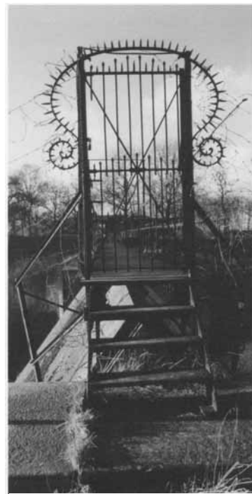
写真8 水門の現状 (エフェールディンゲン水門)
