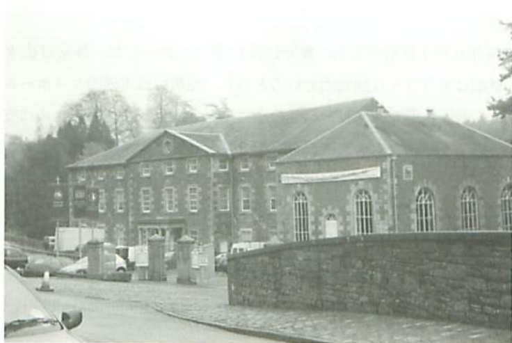
第5図 修復されたインスティテュート
