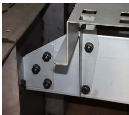
【Photo1.1】 薄鋼板を使用した組み立て式補強構造
