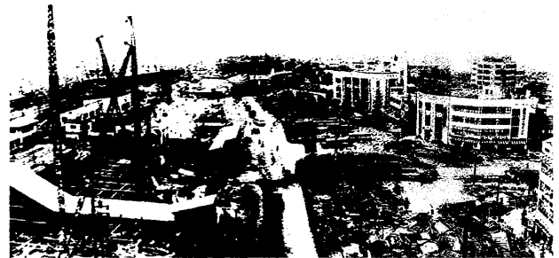
写真7 昭和28年完成近い池袋駅東口広場 （出典：写真でみる豊島区50年のあゆみ）
