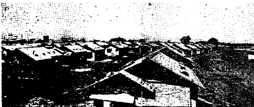
図4-1 工事中の星が丘住宅
