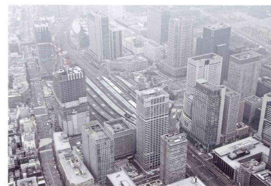
pic4.1-11 東京駅八重洲口再開発
