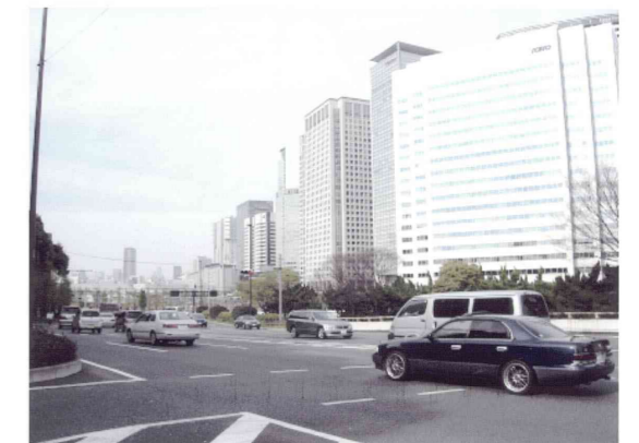
pic4.1-10 品川インターシティ
