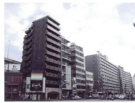
高速の西側に建つ高層ビルの壁
