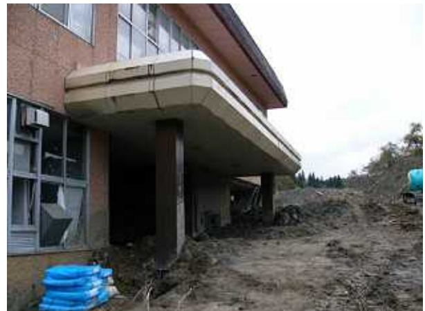
図4 地盤の変動による被害
