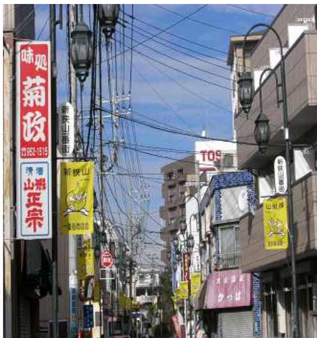
(a) 電柱施工
