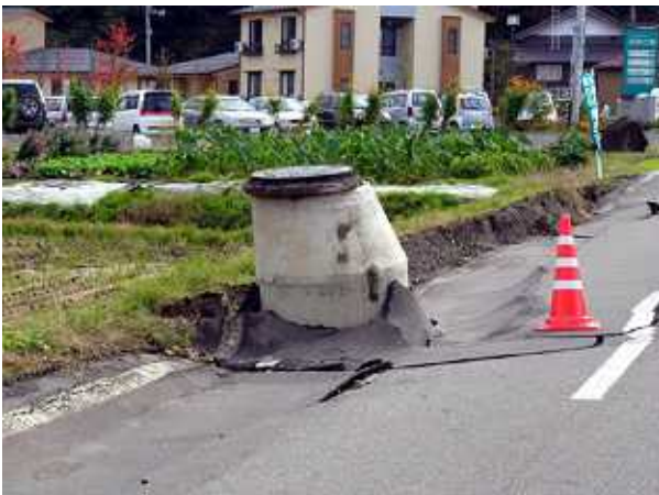
図4 地盤の変動による被害
