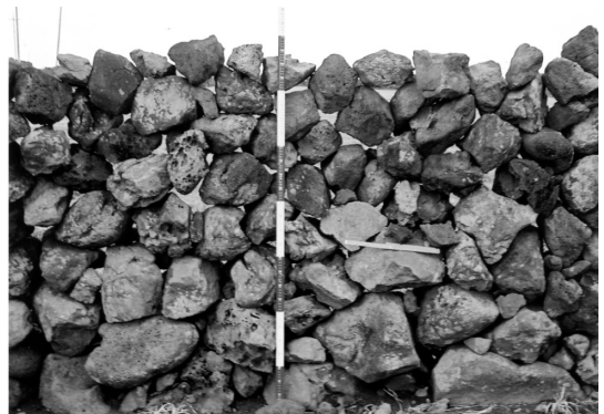
写真2 （左）済州島北海岸の内都洞付近に分布する畑の防風石垣 （右）直径30～50cmの玄武岩の火山礫を用いた石垣。石積みは一列で、風は吹き抜けるが弱まる。
