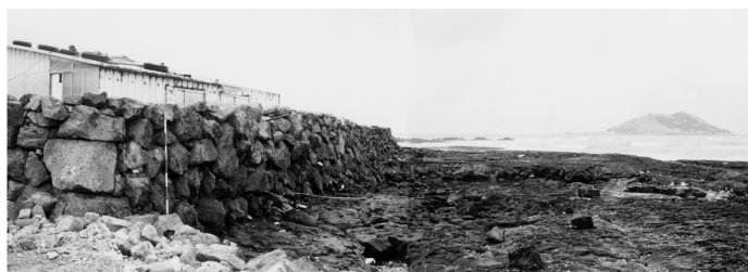
写真4 済州島北西海岸帰德里における防風石垣 (左) 内陸側に立地する屋敷囲い。高さ 1.5m。 (右) 海岸に立地する屋敷囲い。高さ 2.2m。
