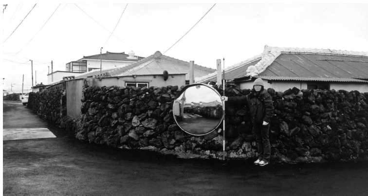
写真3 内都洞集落における曲率を持って築かれた石垣。玄武岩の火山礫を用いた屋敷囲い。
