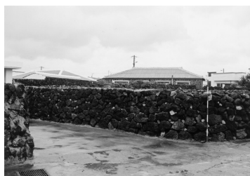
写真3 内都洞集落における曲率を持って築かれた石垣。玄武岩の火山礫を用いた屋敷囲い。
