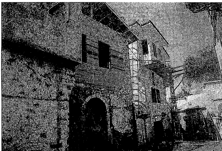
写真8 工事中のペンション
